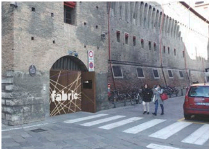
INGRESSO Via IV Novembre
